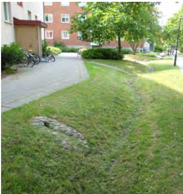
Figur 9: Exempel på Svackdike. Källa: RG dagvattenhandbok.
