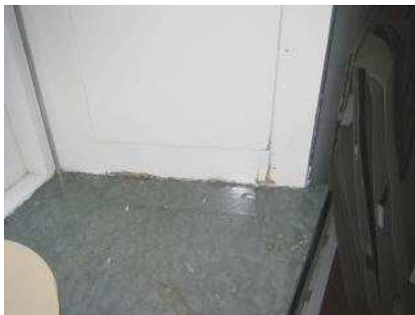
Fönstersmygar med målade träspeglar och fönsterbräda av marmor från 1959.
