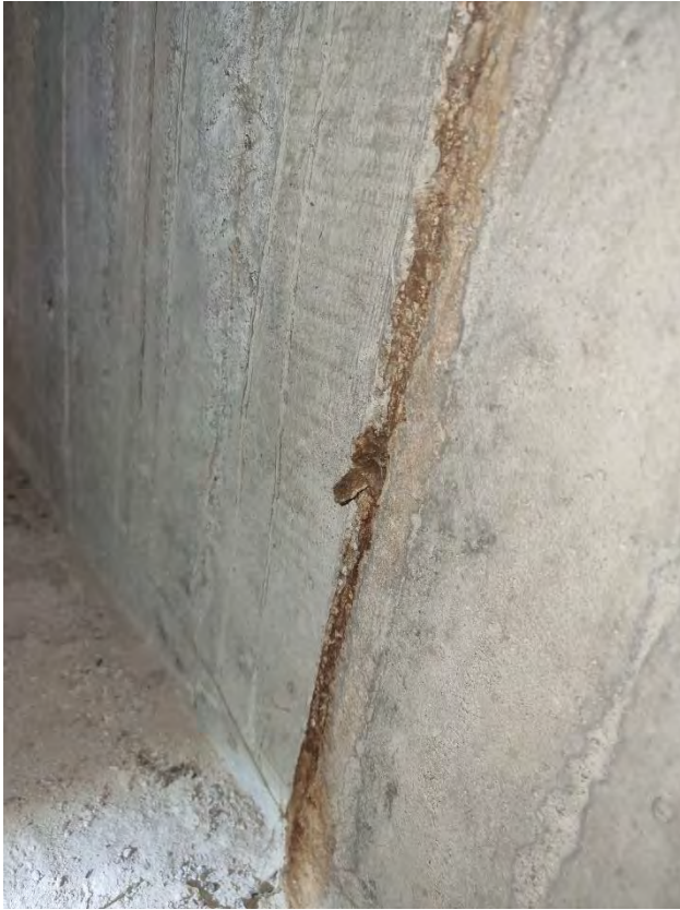
Figur 48 gjutfog asfaboard
