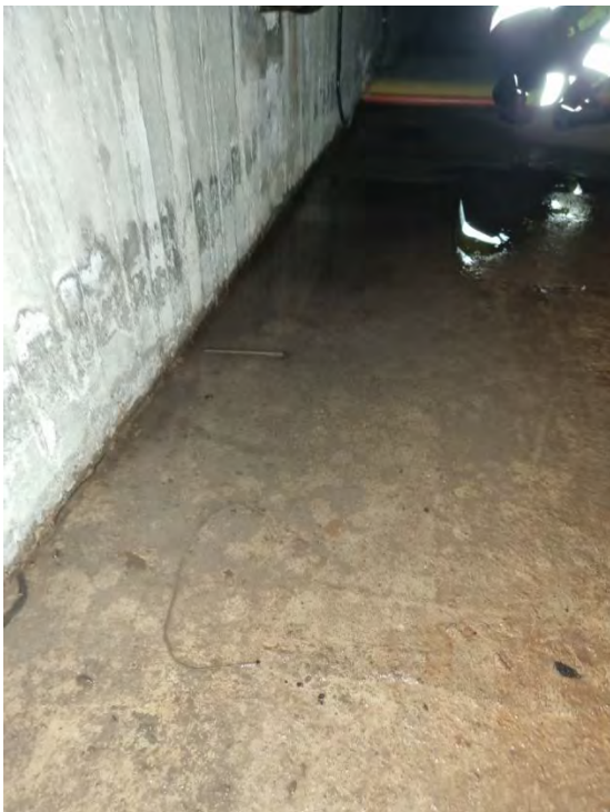
Figur 46 Vattensamling kulvertgolv
