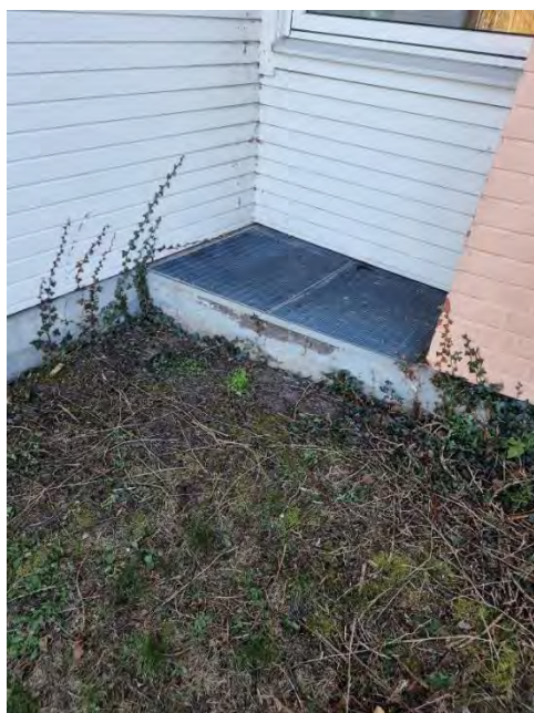
Figur 11 Schakt ner till dörr till kulvert
