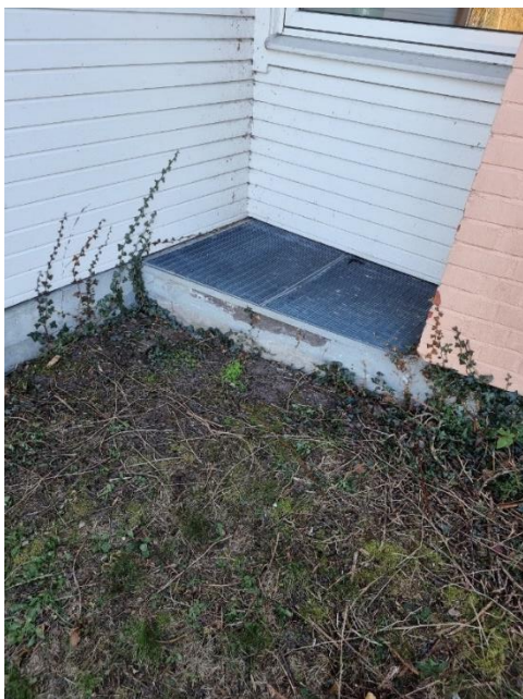
Figur 11 Schakt ner till dörr till kulvert
