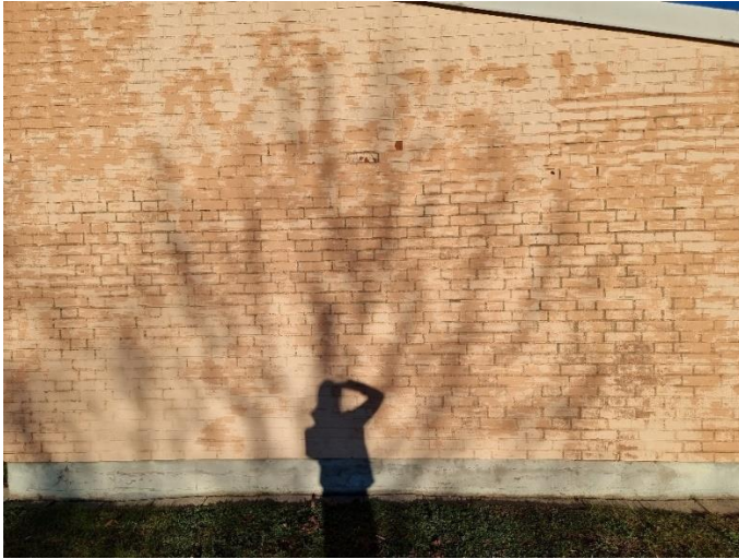
Figur 15 delvis Frostsprängt tegel
