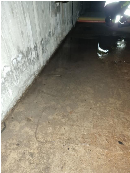
Figur 46 Vattensamling kulvertgolv
