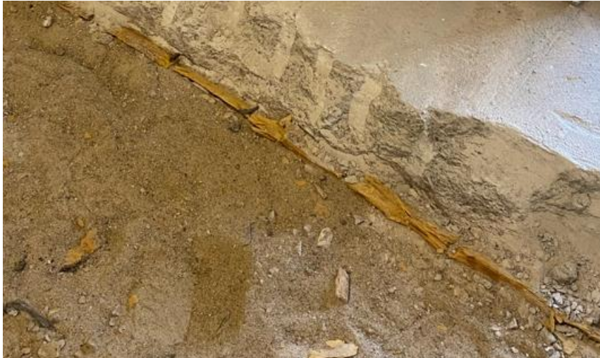
Figur 8 Träregel under betong
