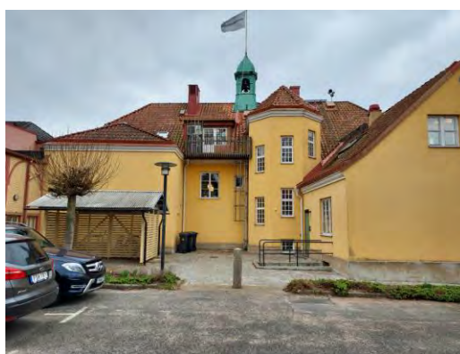
Fig. 12. Trapphus med balkong.
