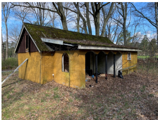
Rester från tidigare verksamhet i norra delen av området.
