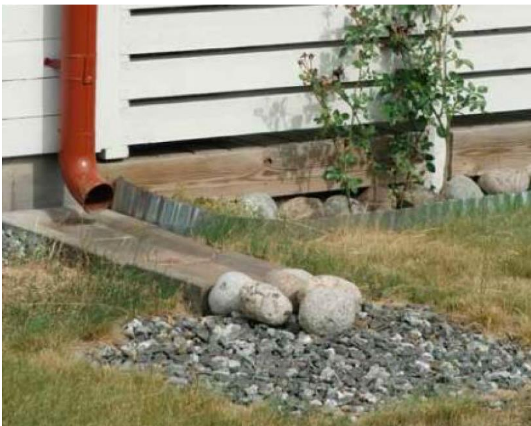
Figur 7: Stuprörutkastare med rännalsplattor och erosionsskydd som leder ut vattnet på gräsmattan. Foto: Dagvattenhandbok, Haninge kommun 2019.
