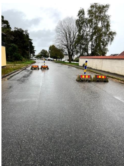
Figur 8: Hastighetsdämpande åtgärder på Hanöhusvägen
