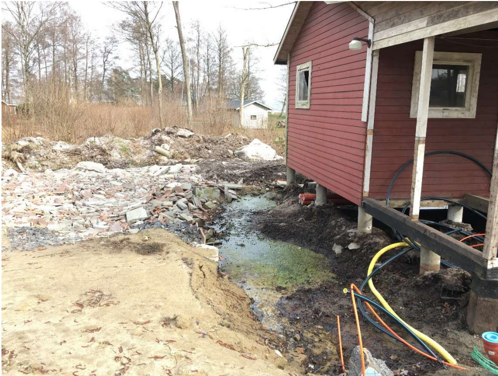
Området runt huset är sankt. Huset står på plintar.
