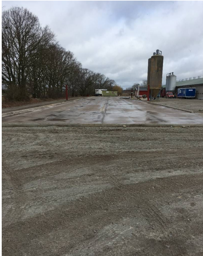
Bilden ovan visar befintlig platta från nedbrunnet broilerstall.
