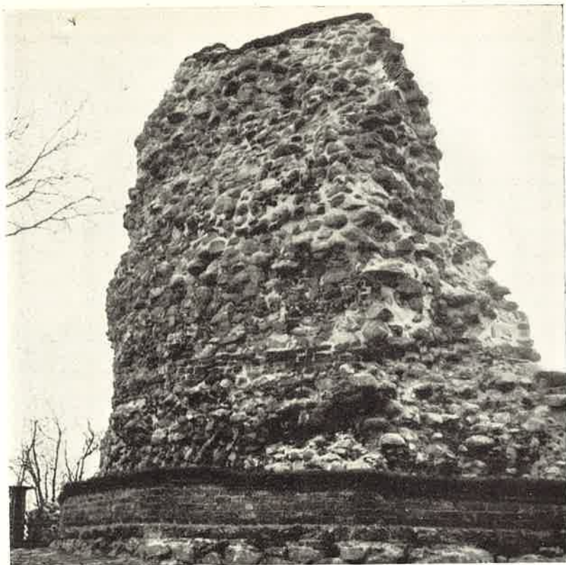
Bild 1. Sölvesborgs slott. Tung och mäktig reser sig det gamla försvarstornets nordvägg. Nedtill synes det rekonstruerade nedre partiet av tegelbeklädningen.
