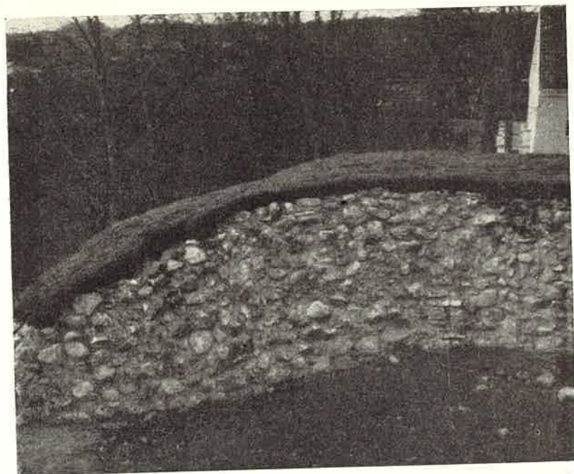
Bild 8. Samma parti som på föregående bild. De isärglidande och trasiga murstumparna ha stöttats upp, murats ihop och delvis bakats in i nytt, hållbart murverk, varigenom inte bara styrka vunnits utan också ett intryck av helhet skapats.
