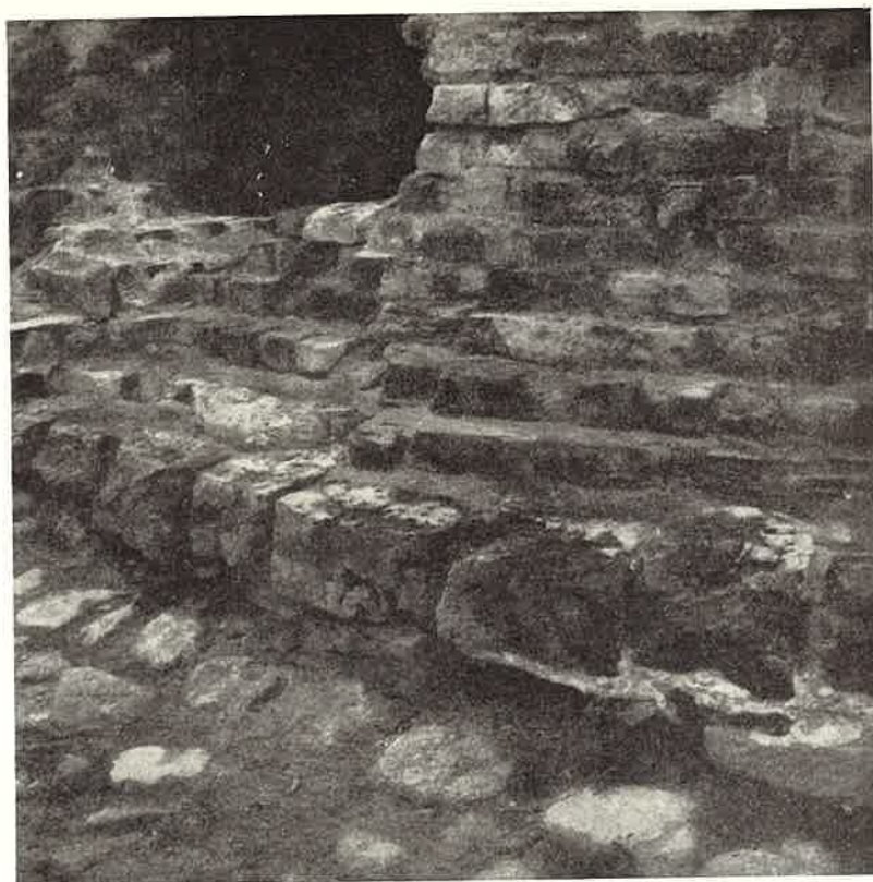
Bild 5. Övergången från grunden till tegelkåpan har förmedlats av dessa stora skråkantade fristegel, en gång vackert glaserade i mörkgrönt och svart.
