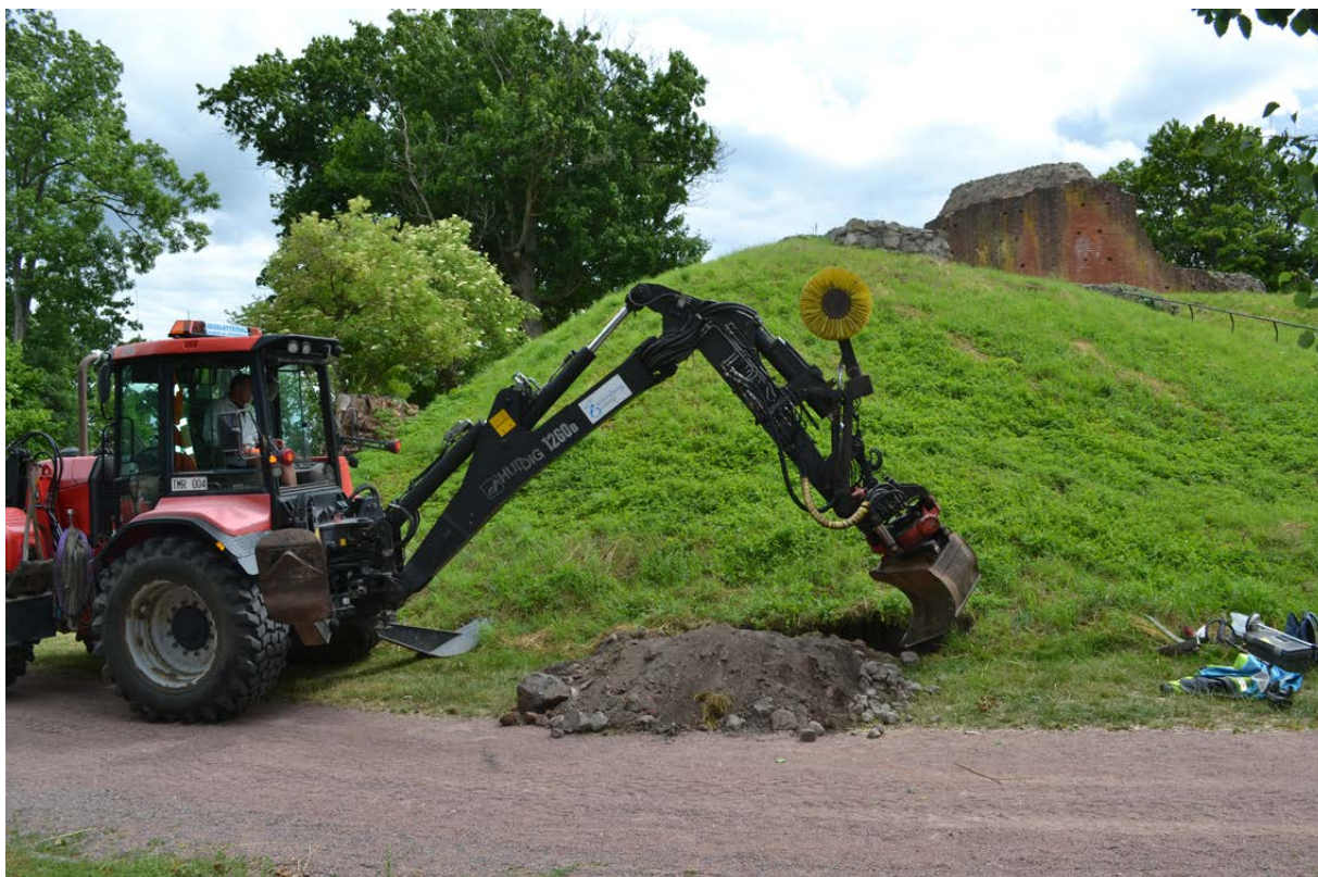
Figur 5. Maskingrävning nedanför den norra sidan av borgkullen (schakt 15). Foto taget från norr.
