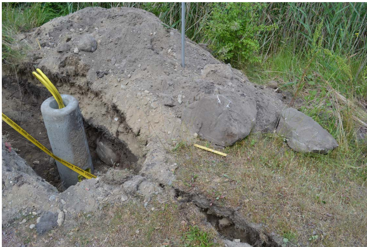
Figur 10. Schakt 12 låg alldeles intill platsen för den inre vallgraven. Här påträffades en stenpackning som möjligen skulle kunna höra samman med en stensatt strandskoning längs den inre vallgravens utsida. Upptagna stenar ligger bredvid schaktet. Foto taget från öster.
