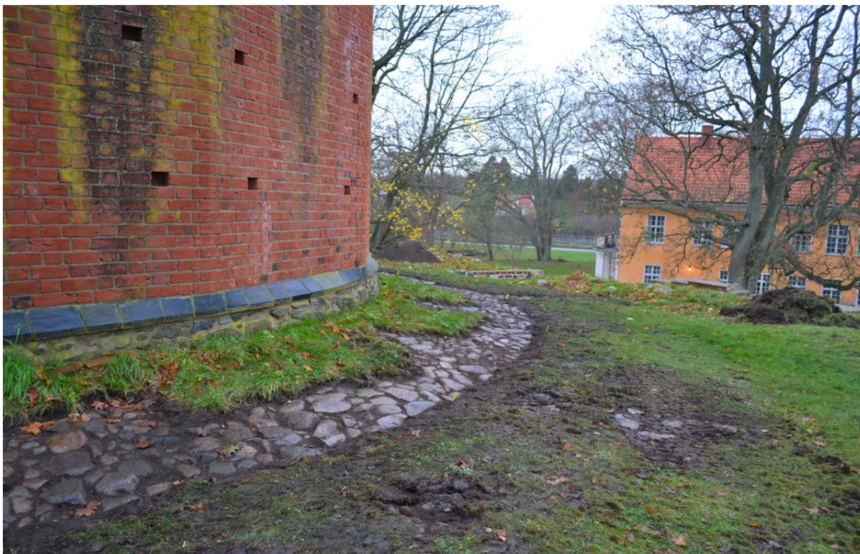
Figur 20. Vid den inledande schaktningen rensades den stenläggning, A16, fram som täckt borggården. Foto av stenläggningen vid tornets norra sida, taget från nordöst.
