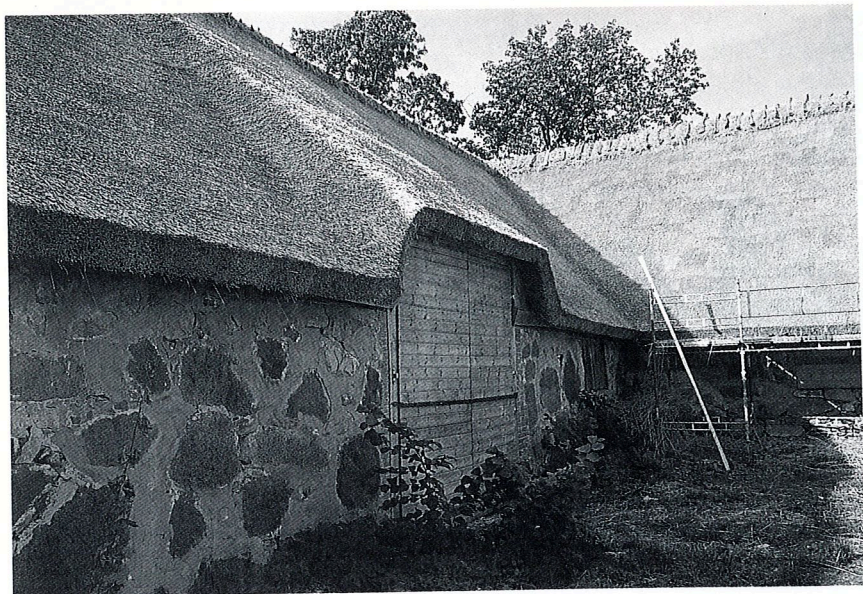
Detalj av uthuslängorna med nylagt vasstak. — Foto: Jonte Göransson 1994.
